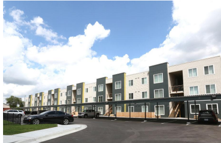
The Flats 324 Modern
