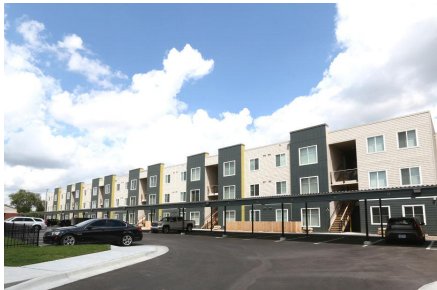
The Flats 324 Modern
